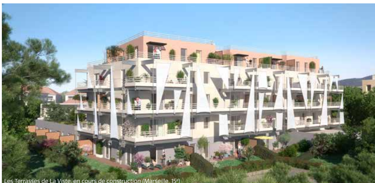
Les Terrasses de La Viste, en cours de construction (Marseille, 15 e )
