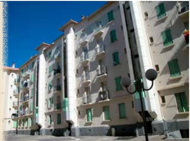
Clovis Hugues, construit en 1935
